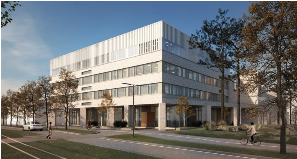
Kuva 9: Aviapoliksen lukio, rakenteilla
