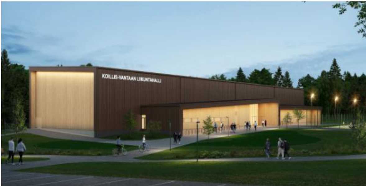
Kuva 10: Koillis Vantaan liikuntahalli, rakenteilla
